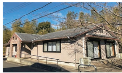
さくら自治会館全景
