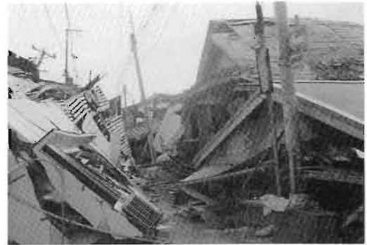
阪神・淡路大震災の倒壊家屋。木造建物の1階部分が潰れている。 出典：「地震の日本史」寒川旭著（中公新書）
