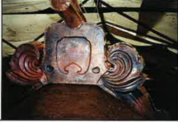
『魁』という。鬼瓦に相当する。岡本さんは、裏打ち出しの技法で加工できる第一人者で、写真は豊国神社の鬼である。
