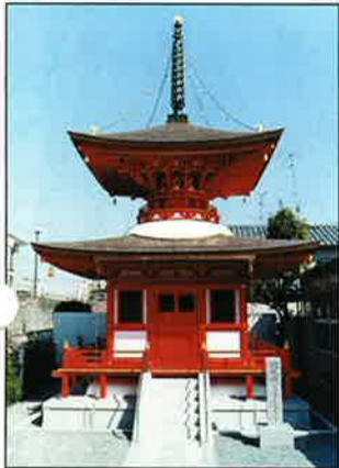
右京の成願寺の多宝塔の屋根の「銅板葺き」と「とどい」を施工された。
