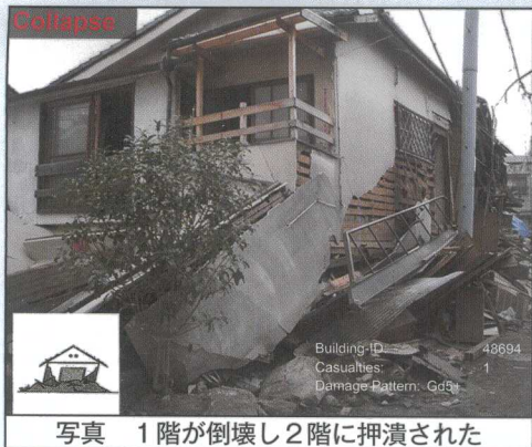
写真 1階が倒壊し2階に押潰された
