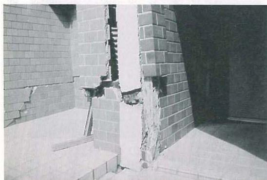
写真9 タイル張りの内部で腐食した柱
