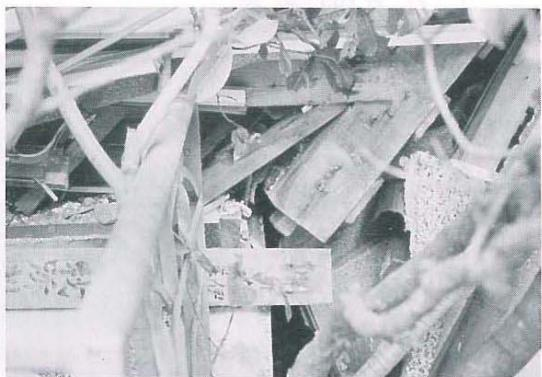
写真7 柱の土台からの抜け
