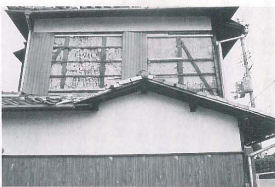
写真8 筋かいや外壁の面材が効いている例
