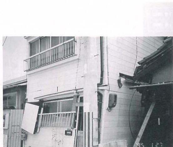
写真4 1階間口方向の壁が不足している住宅
