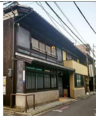
〈町家を事務所に改修〉 大堀町・事務所
