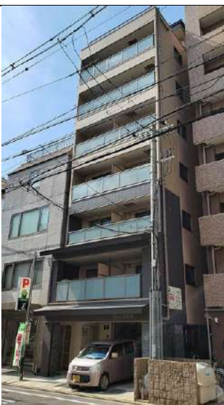
〈外壁を明るい色に変更〉 玉津島町・共同住宅
