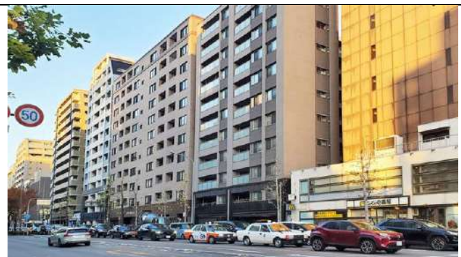
〈マンション町内会として修徳自治連合会に加入〉 玉屋町・共同住宅
