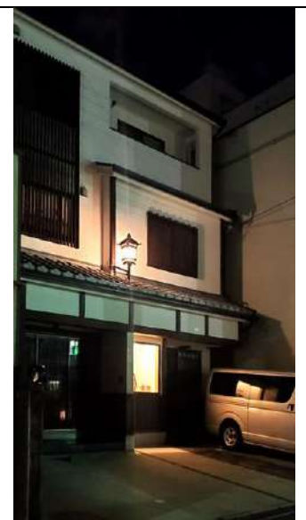
〈夜間照明を設置〉 中野之町・事務所
