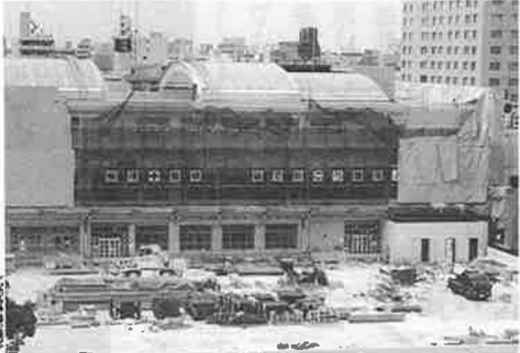
△運動場(2F)はこれから。北側の校舎工事用網もまだとれていません。 ▽校舎の東側はもう姿をあらわしています。
