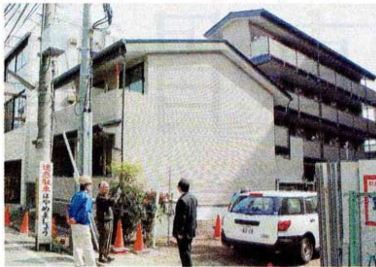
修徳学区で建設が進むマンション。住民側の要望を受け、ベランダの柵の色合いなどが変更された（京都市下京区）
